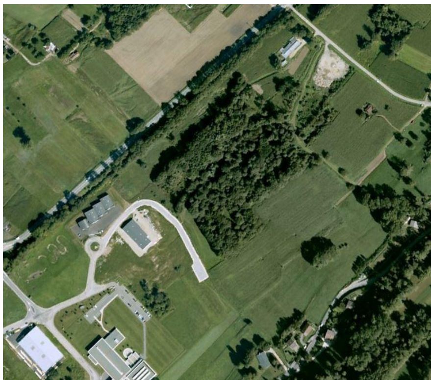
Figure 17 : Photographie aérienne en 2006, avant travaux de viabilisation (Source : Google earth)
